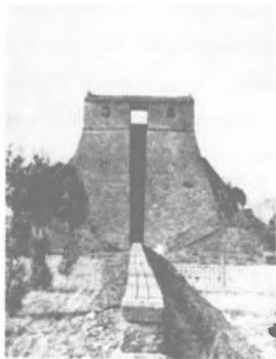
شکل ۶۵. برج چو کونگ، مقیاس افقی اندازه‌گیری سایه همراه با طراز آبی.
